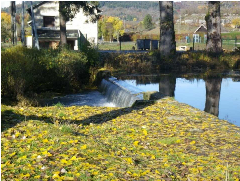
Obstacle sur l'Albarine (seuil)
